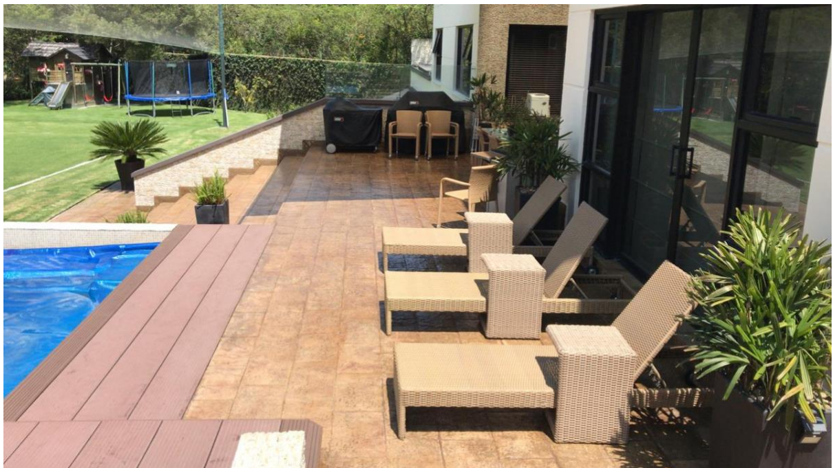
FIGURE 4 DESPUES DE APLICACIÓN DE SELLADOR PROTEX PROSEAL ACABADO BRILLANTE [OBRA LARREA CUMBAYÁ, PICHINCHA]
